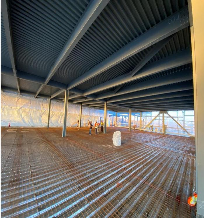
*Pictured: OmniaBio B Level 3 pour 1 slab on deck ready to pour*
